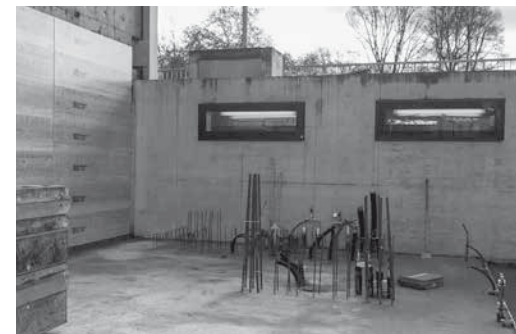
Vorbereitung der Fundamente und Anschlüsse des Annexbaus an den bestehenden Ergänzungsbau (Gebäude G)
